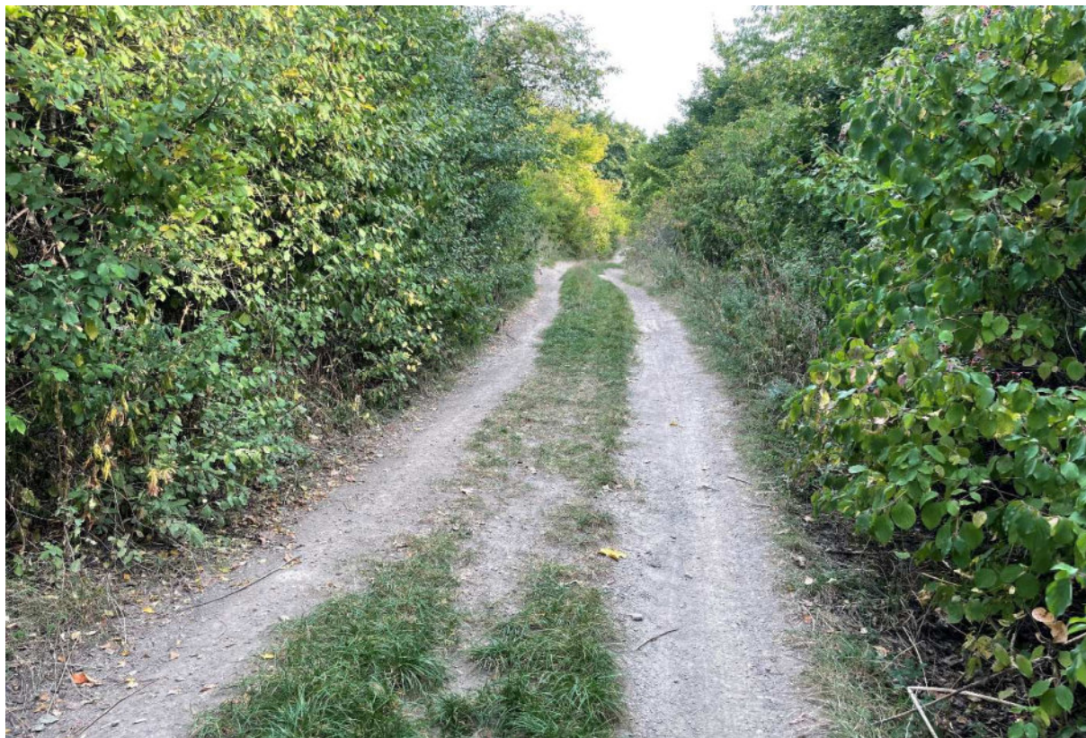
Obr. č. 9: Poľná cesta P-1 v úseku 1 obvodu
