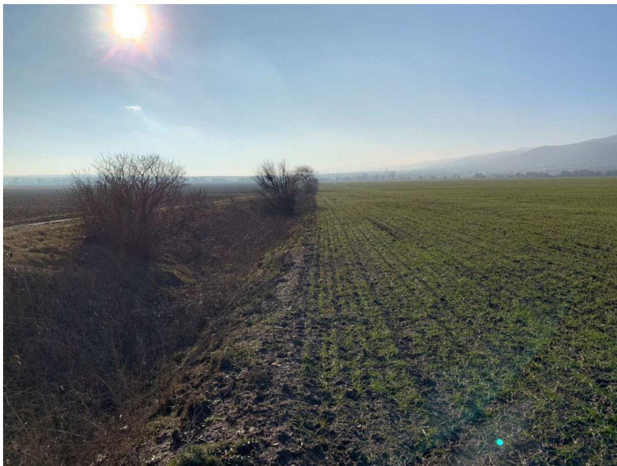
Obr. č. 18: Odvodňovací kanál OK-2
