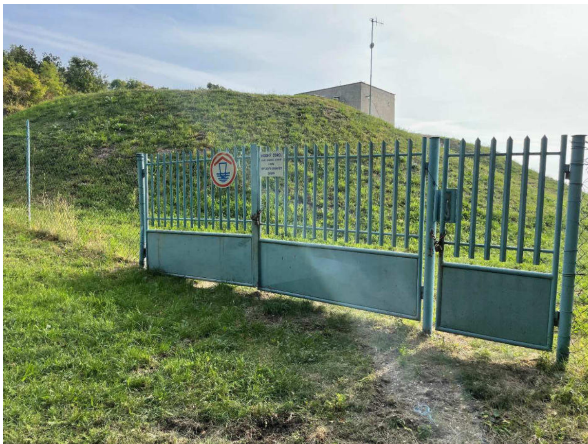
Obr. č. 23: Zemný vodojem
