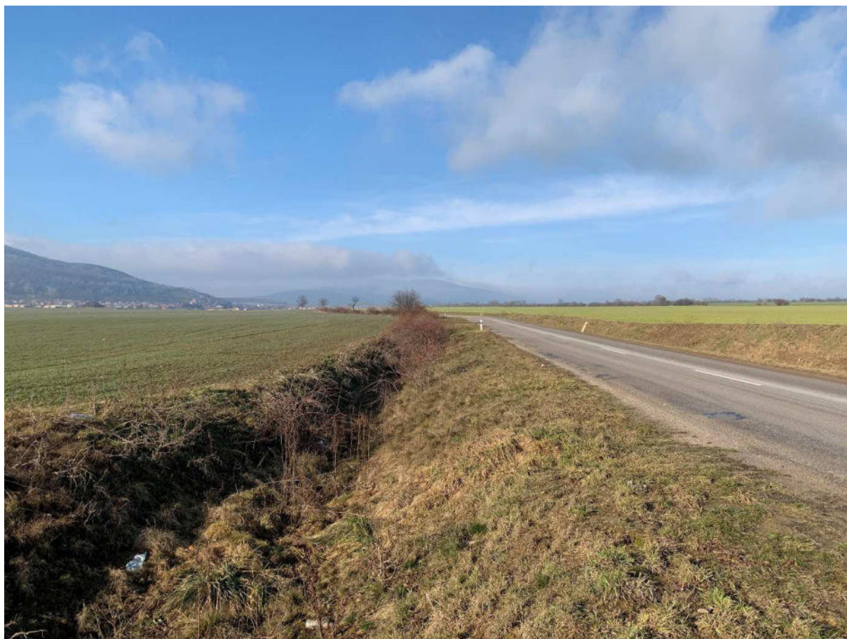
Obr. č. 19: cesta III. triedy Suchá nad Parnou – Horné Orešany č. III/1297
