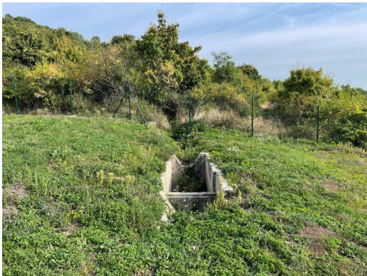
Obr. č. 17: Odvodňovací kanál OK-1
